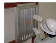
4. 分割されている縦羽根①②を、両端に移動させる。(図1参照)
