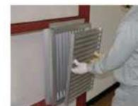
2. 横羽根を取り外します。(取外品の大きさによっては、重量があるので複数的人员で作業することをお奨めいたします。)
