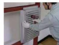
1. 最初に横羽根取り付けビスをブラスドライバー、又はインパクトドライバー等で外します。(取外したビスを紛失しないように！)
