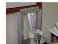
7. 最後のガラリを中央部に移動させ、上方向に持ち上げながら下部を手前に引く。(図4参照)
