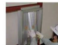
6. 両側のガラリをひとつずつ中央部に移動させ、上方向に持ち上げながら下部を手前に引く。(図2・3参照)
